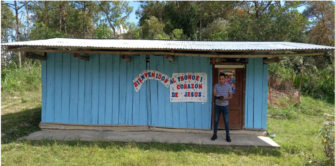
Nota. Observación cargas eléctricas Institución Educativa Inicial.
