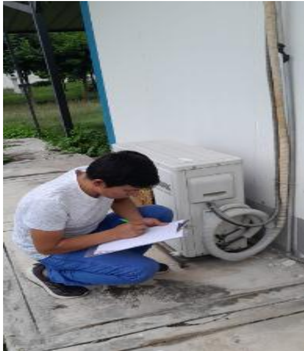
Nota. Unidad exterior del aire acondicionado (Compresor y condensador)
