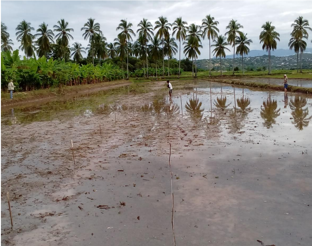
Fotografía 5. Demarcación del terreno y construcción de bordos
